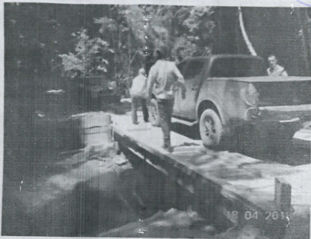
Ponte Pataua de são Jose GPS (S1°56'22.8"W55°15'43.5") – Foto 12
