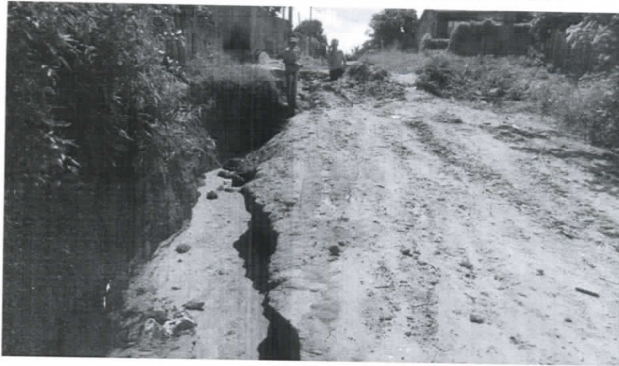
Travessa Raimunda Antonieta Canto com Rua 26 de Julho – Foto 04
